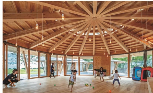
遊戯室内観 各部屋は中心に柱のない持たせ合いの構造でできている。建築全体の回転を妨ぐために壁もしくは方柱を円周部に足している
