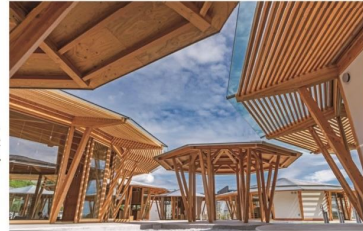
上/足洗い場を見る 下/屋根が折り重なり、軒下が連続することで廊下として利用することができるようになる
